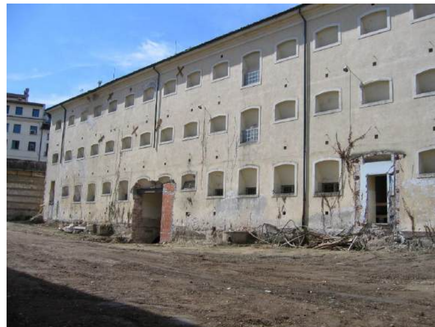
Veduta corte interna porzione ex Carcere Giudiziario
