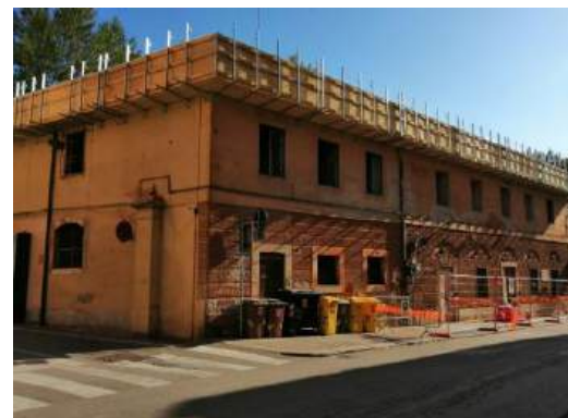
FOTO 5 Facciata lato Sud
